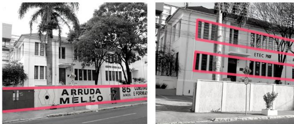
Figura 06 e 07. Implantação do muro e Análises das influências Déco no Colégio Arruda Mello.
