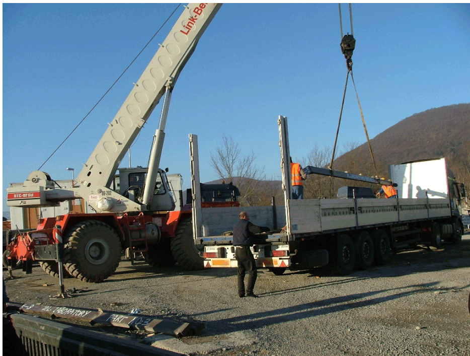
Slika 1. Vanjski transport materijala i opreme 1
