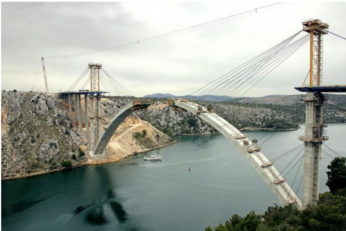
Slika 5. Kabel kran na izgradnji mosta Krka (dionica Skradin-Šibenik) 5
