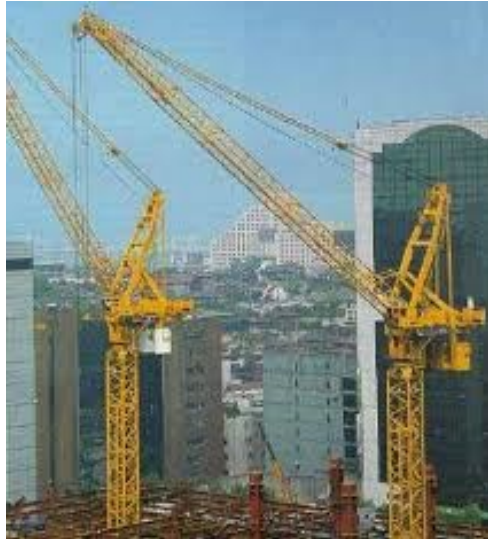
Slika 8. Toranjska dizalica s kosom strijelom 8
