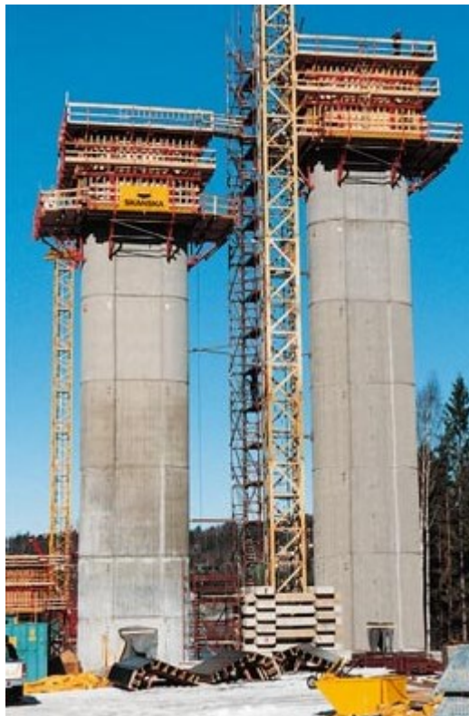
Slika 9. Penjajuća dizalica u kombinaciji s oplatom 9
