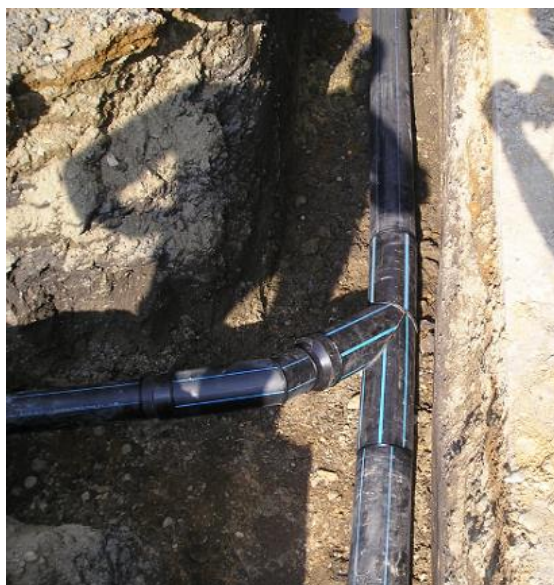
Slika 6.19. Spajanje cijevi na glavnu vakuumsku mrežu u Bečkom petrovcu (Šanta, Č., Fabry, G., 2006.)
