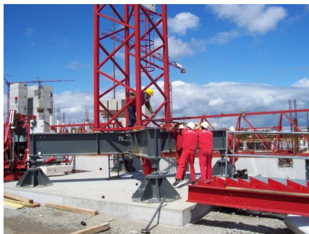
Slika 21. Montaža osnovnog dijela tornja t.kрана; Gradilište: Portanova, Osijek
