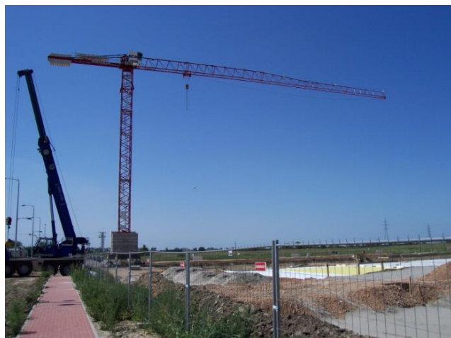
Slika 26. Toranjski kрана LIEBHERR 110 EC-B6 Fr.tronic; Gradilište: Portanova, Osijek
