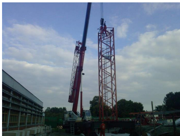
Slika 20. Montaža osnovnog dijela tornja t.kрана; Gradilište: Poljoprivredni fakultet, Osijek,
