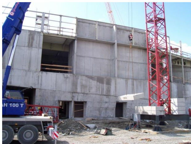
Slika 23. Montaža AB balasta na stacionarno podvozje t.kрана; Gradilište: Portanova, Osijek
