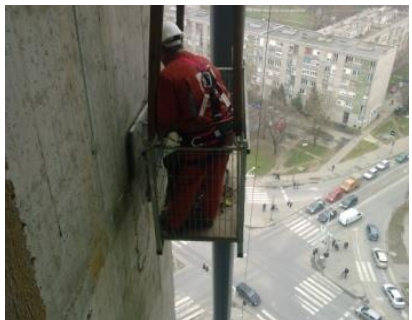
Slike 7. Sidrenje toranjskog kрана LIEBHERR, vanjski toranj; gradilište: Eurodom, Osijek
