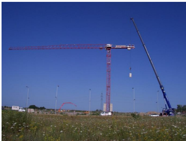
Slika 68. Namještanje kontra-blokova; gradilište: Portanova
