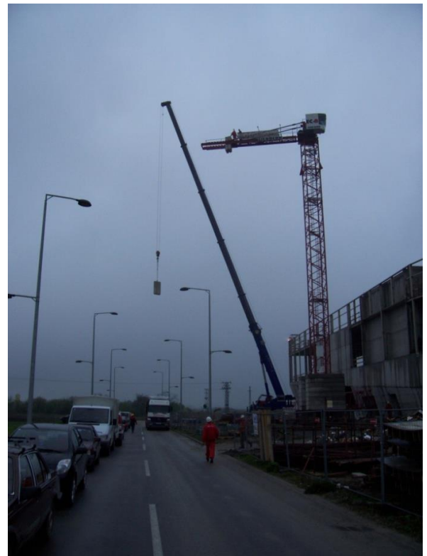
Slika 45. Demontaža kontra-bloka „A“; Portanova, Osijek
