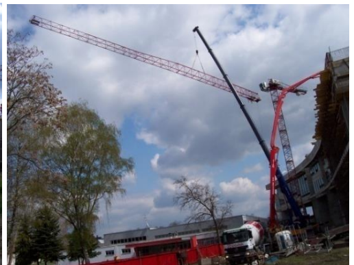
Slika 52. Demontaža ruke; gradilište: Poljoprivredni fakultet, Osijek
