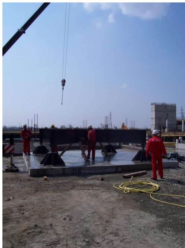
Slika 15. Montaža stacionarnog podvoznog križa t.kрана na predhodno pripremljenoj AB ploči.
