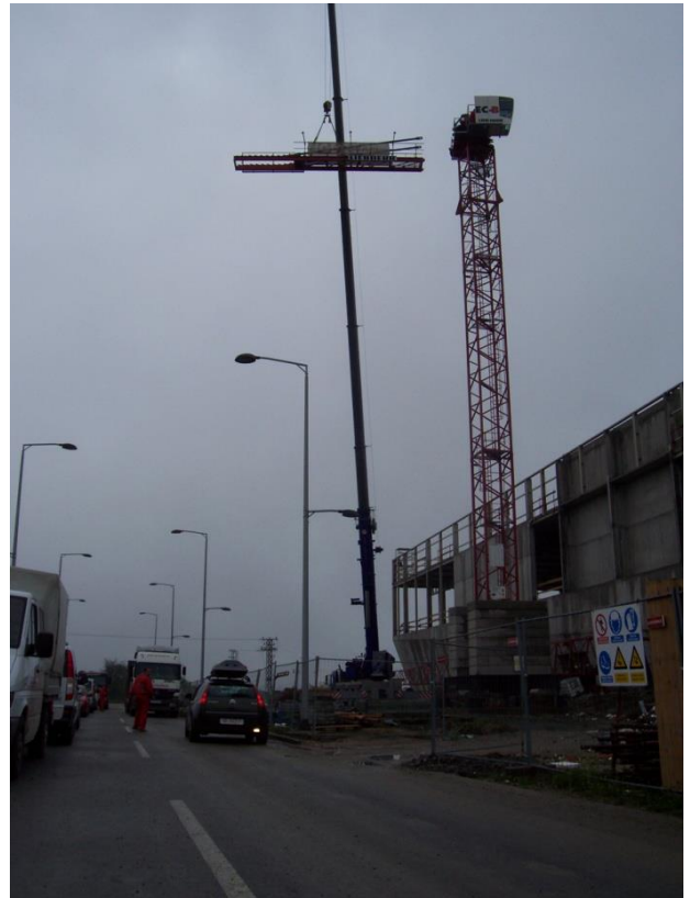
Slika 41. Deontaža kontra-ruke; gradilište: Portanova Osijek
