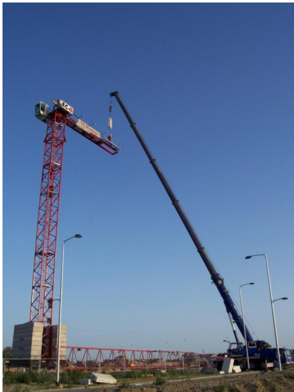
Slika 44. Montaža kontra-bloka „A“; Portanova, Osijek
