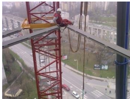
Slike 7. Sidrenje toranjskog kрана LIEBHERR, vanjski toranj; gradilište: Eurodom, Osijek
