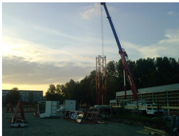
Slika 24. Montaža AB balasta na stacionarno podvozje t.kрана; Gradilište: Poljoprivredni fakultet, Osijek
