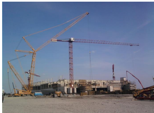
Slika 27. Toranjski kрана LIEBHERR 110 EC-B6 Fr.tronic; Gradilište: Portanova, Osijek
