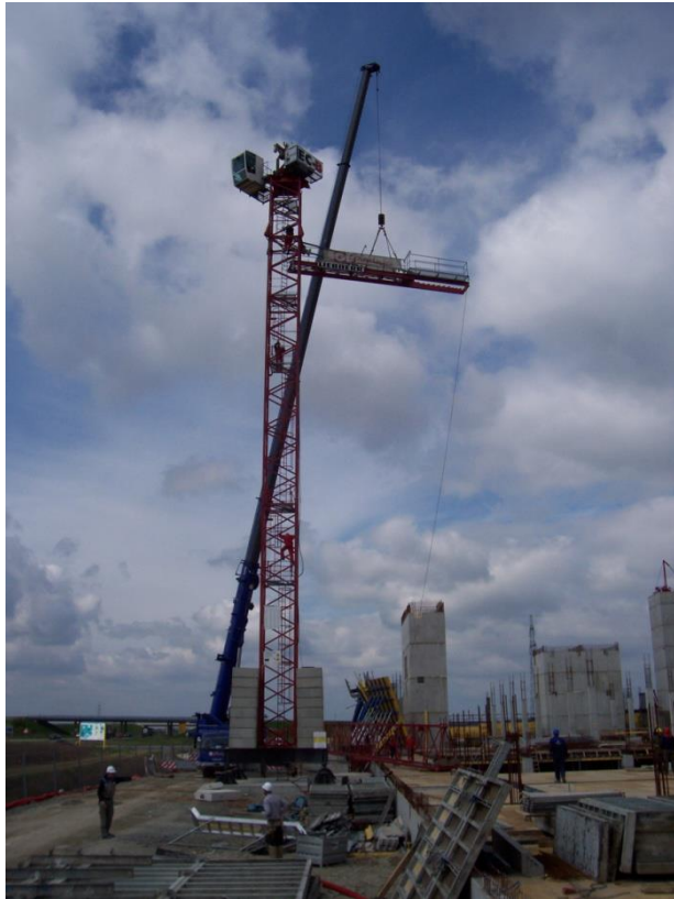
Slika 40. Montaža kontra-ruke; gradilište: Portanova, Osijek
