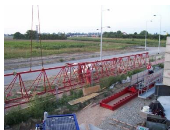
Slike 47. Pred-montaža ruke; gradilište: Portanova, Osijek
