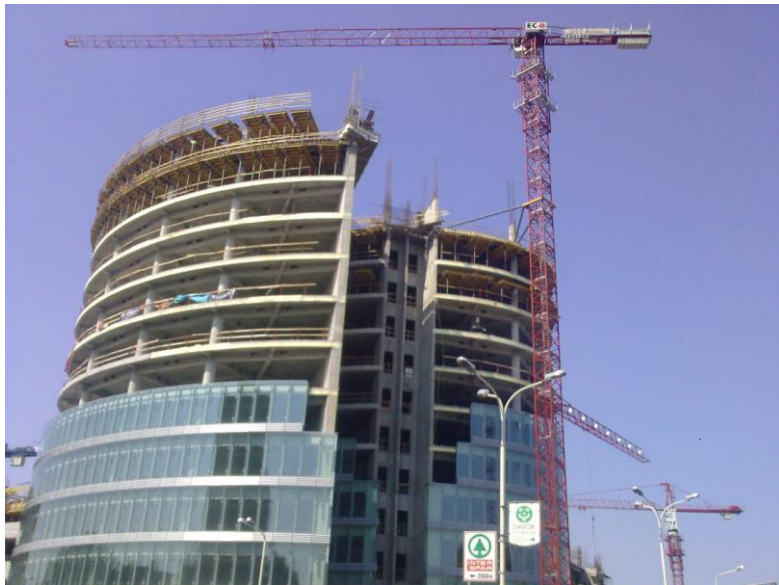
Slika 28. Toranjski kran LIEBHERR 110 EC-B6 Fr.tronic; gradilište: Eurodom, Osijek
