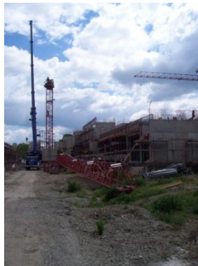
Slika 51. Pred-montaža ruke; gradilište: Poljoprivredni fakultet, Osijek
