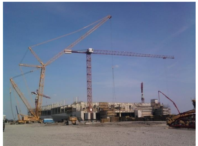
Slika 80. Toranjski kran LIEBHERR 110EC-B 6; gradilište: Portanova, Osijek
