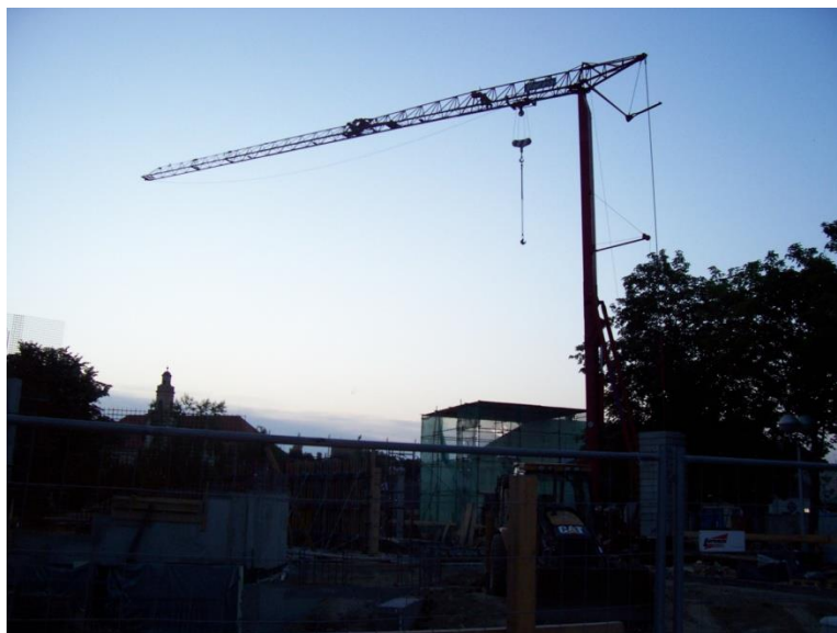
Slika 11. Toranjski kran FERING, gradilište: Kulturni centar, Valpovo
