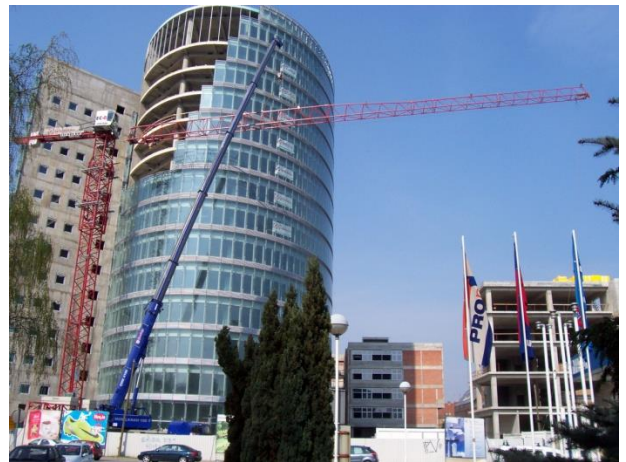
Slika 63. Demontaža ruke; gradilište: Eurodom, Osijek
