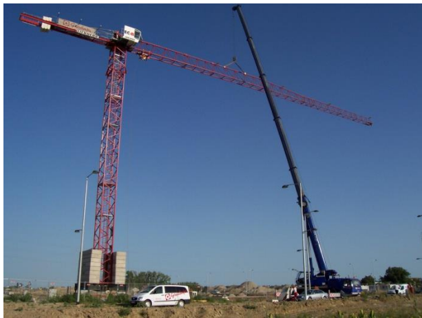
Slika 62. Montaža ruke; gradilište: Portnova, Osijek
