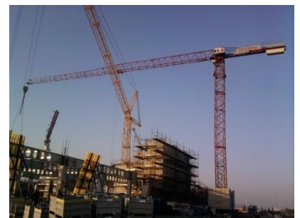
Slika 3. T. kran LIEBHERR
