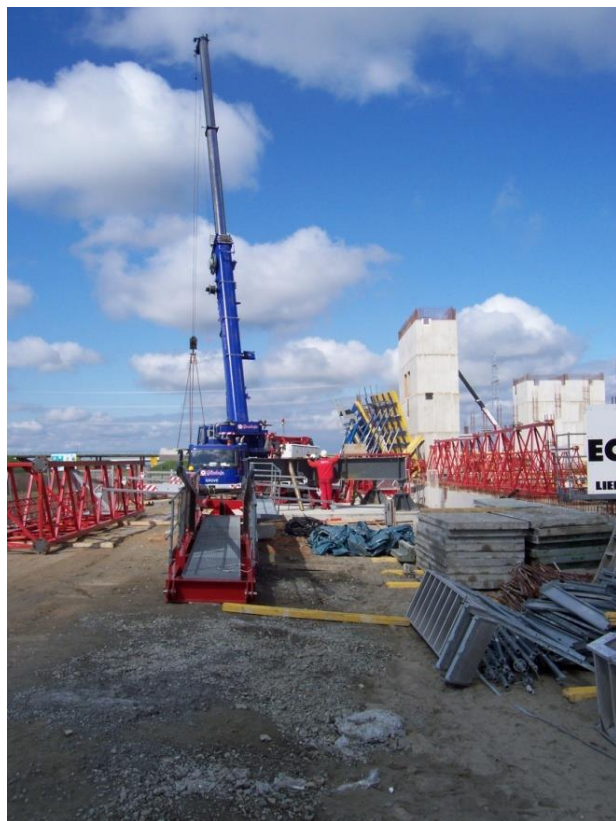
Slika 14. Montaža stacionarnog podvoznog križa t.kрана na predhodno pripremljenoj AB ploči.
