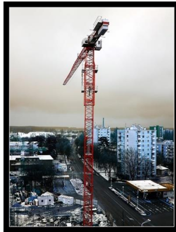
Slika 2. T. kran LIEBHERR [7]
