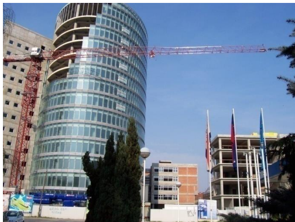
Slika 73. Demontaža užeta za dizanje tereta; gradilište: Eurodom, Osijek
