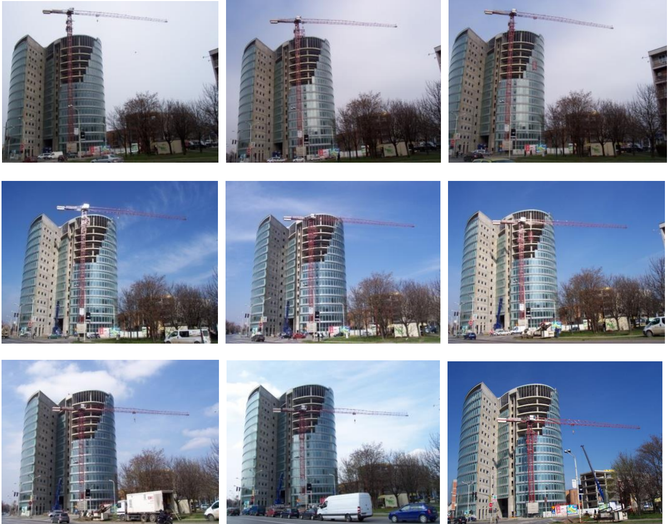
Slike 8. Dio demontaže toranjskog kрана LIEBHERR, gradilište: Eurodom, Osijek
