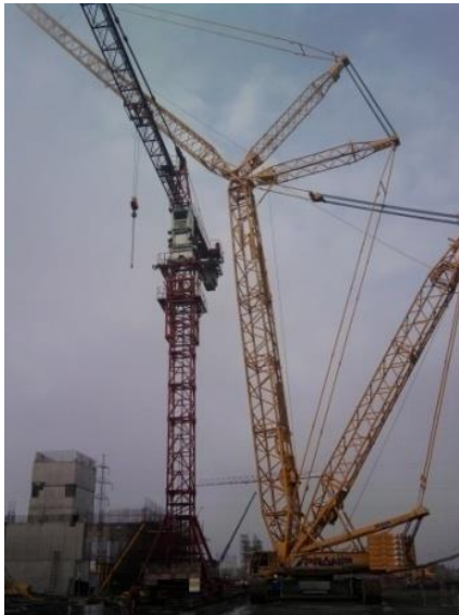
Slike 9. Toranjski kranovi: HC 90,
