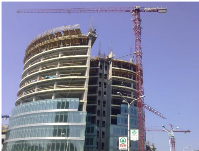
Slika 79. Toranjski kran LIEBHERR 110EC-B 6, usidren za zgradu; gradilište: Eurodom, Osijek
