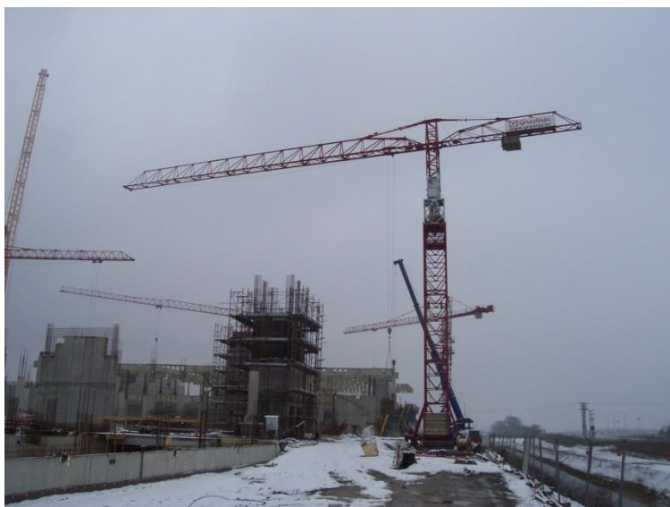
Slika 12. Toranjski kran X1266Y, gradilište: Portanova, Osijek
