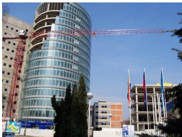
Slika 66. Demontaža ruke; gradilište: Eurodom, Osijek
