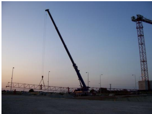
Slika 50., Pred-montaža ruke; gradilište Portanova, Osijek
