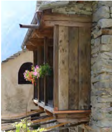
Figura 11 Loggia con mensole sottoposte. Veglio-Montecrestese (VB)
