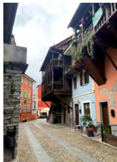
Figura 8 Loggia con saette e passafuori a tutta falda.
