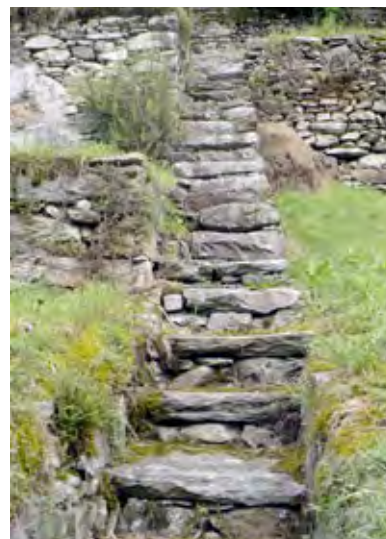
Figura 10 Scalinata di accesso ai terrazzamenti, realizzata con grandi lastre, di Pontegrande, Bannio, Valle Anzasca.
