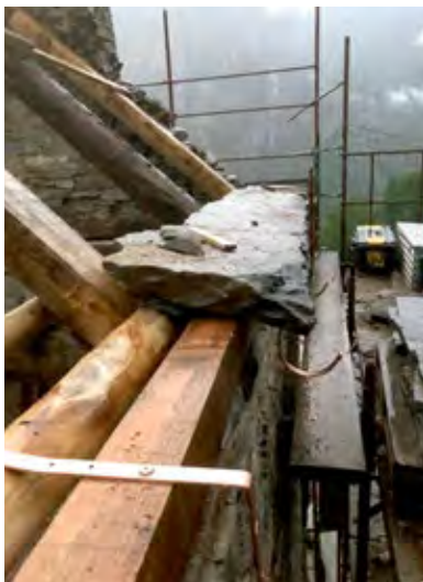
Figura 21 Canali di gronda: fissaggio dei supporti dei canali prima della posa del primo corso di lastre del manto (cfr. Figura 22A).
