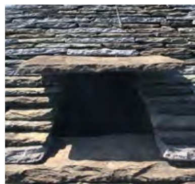
Figura 36 Vista frontale di varco di passaggio per ispezione esterna del manto. Cappella di Abramo - Sacro Monte di Ghiffa. Arch. Scotton.
