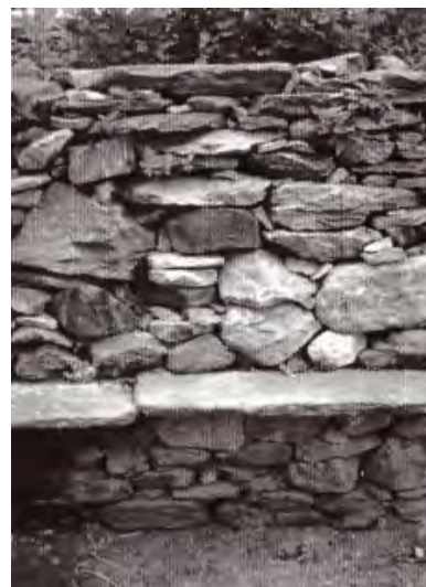
Figura 1 Apparecchiatura microlitica: muro di recinzione con seduta e copertina di piode, chiesa di San Giulio e Filippo. Pianezza di San Carlo, Valle Anzasca. Il muro esteso per circa 15 m e alto circa 1,5 m spesso 80 cm circa alla base, potrebbe essere opera di un solo muratore, nessuno dei suoi elementi richiede forza lavoro maggiore.
