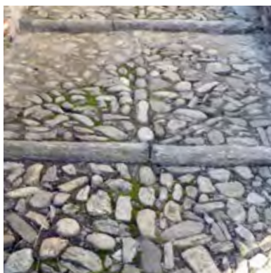
Figura 5 Rampa acciottolata con cordoni in piode di coltello, Canton Gorini, Vanzone, Valle Anzasca.
