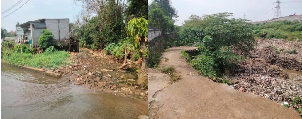
Gambar 2. Banjir dan longsor akibat sampah TPA
