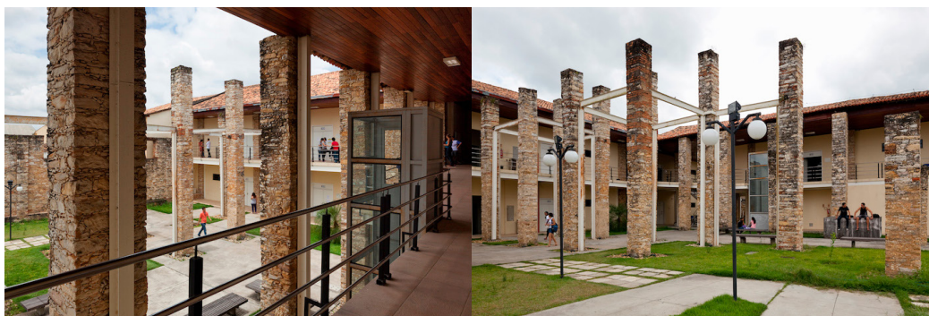
Figura 9. Vistas da praça interna da UFS, Campus Laranjeiras (SE) Fonte: Nelson Kon [s.d.]. Acervo Iphan.
