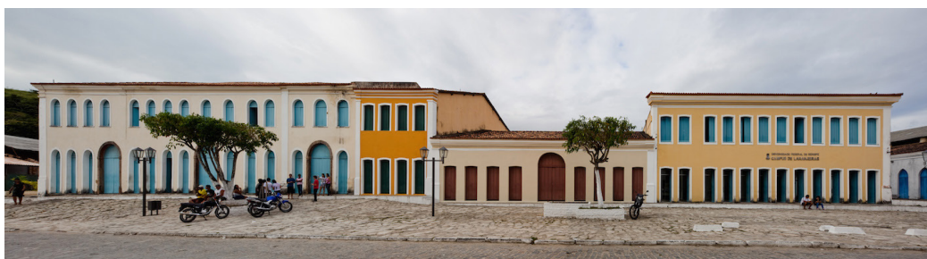
Figura 7. Universidade Federal de Sergipe, Campus Laranjeiras (SE), implantada no Quarteirão dos Trapiches
