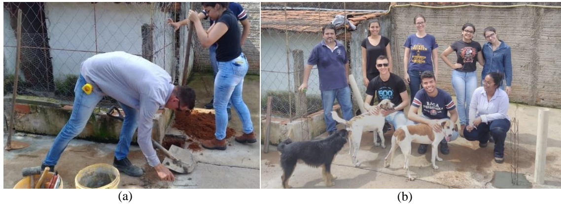
Figura 5 – (a) Etapa de escavação para execução da estaca e (b) grupo presente no primeiro encontro
