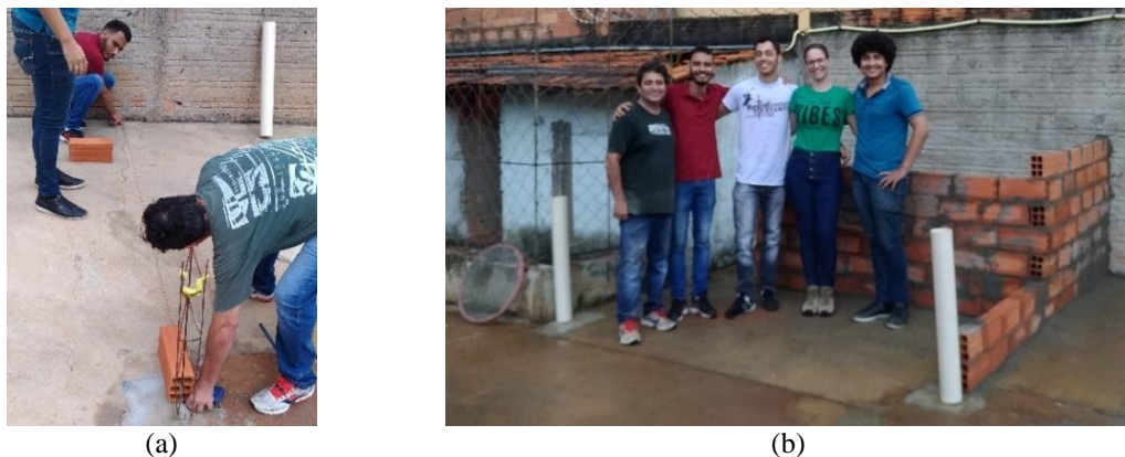
Figura 6 – (a) Etapa de marcação da alvenaria e (b) grupo presente no segundo encontro
