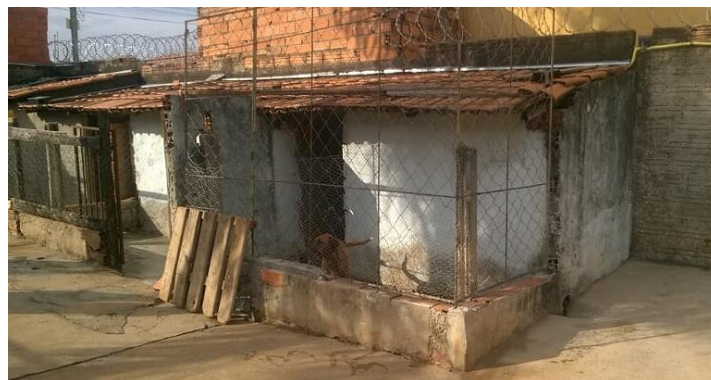
Figura 2 – Baias existentes no Abrigo Independente Paraíso de Cães
