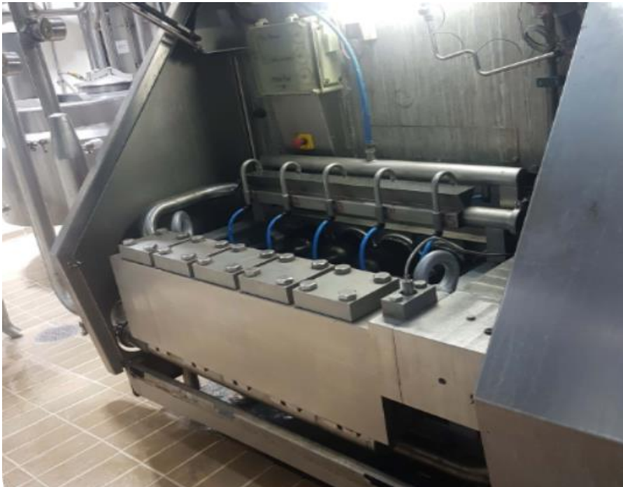
Figura 5 Sistema de enfriamiento de pistones.
