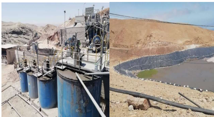
Figura N°3: Vista de los tanques de recuperación y cancha de relave de la planta DA-CREIN. Fuente: Propia (2022)
