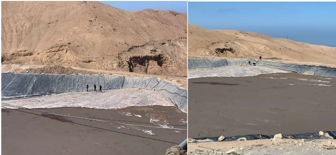
Figura N°5: Toma de muestras de relave aurífero cianurado de la planta DA-CREIN. Fuente propia (2022)
