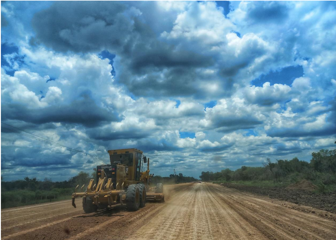
FIGURA 2: TRABAJOS DE PAVIMENTACIÓN
