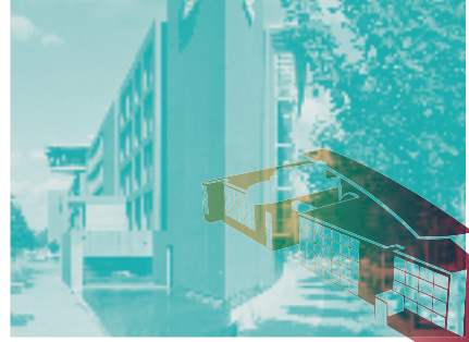
HAUPTVERWALTUNG DER SPARKASSEN-VERSICHERUNG SACHSEN (ATRIUM) AN DER FLUTRINNE 12 01139 DRESDEN
