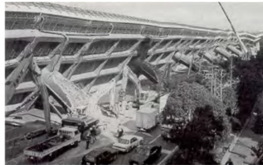
Slika 2. Higashi-Nada vijadukt, rušenje 1995 Kobe zemljotres, (prema Duan L., Li F. 2000)
