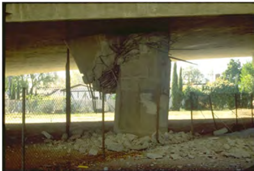
Slika 1. Smičući lom, 1971 San Fernando zemljotres, (prema Folić B. I R. 2018)
