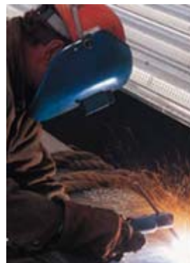
Slika 4. Elektrolučno zavarivanje / Figure 4. Arc welding.
