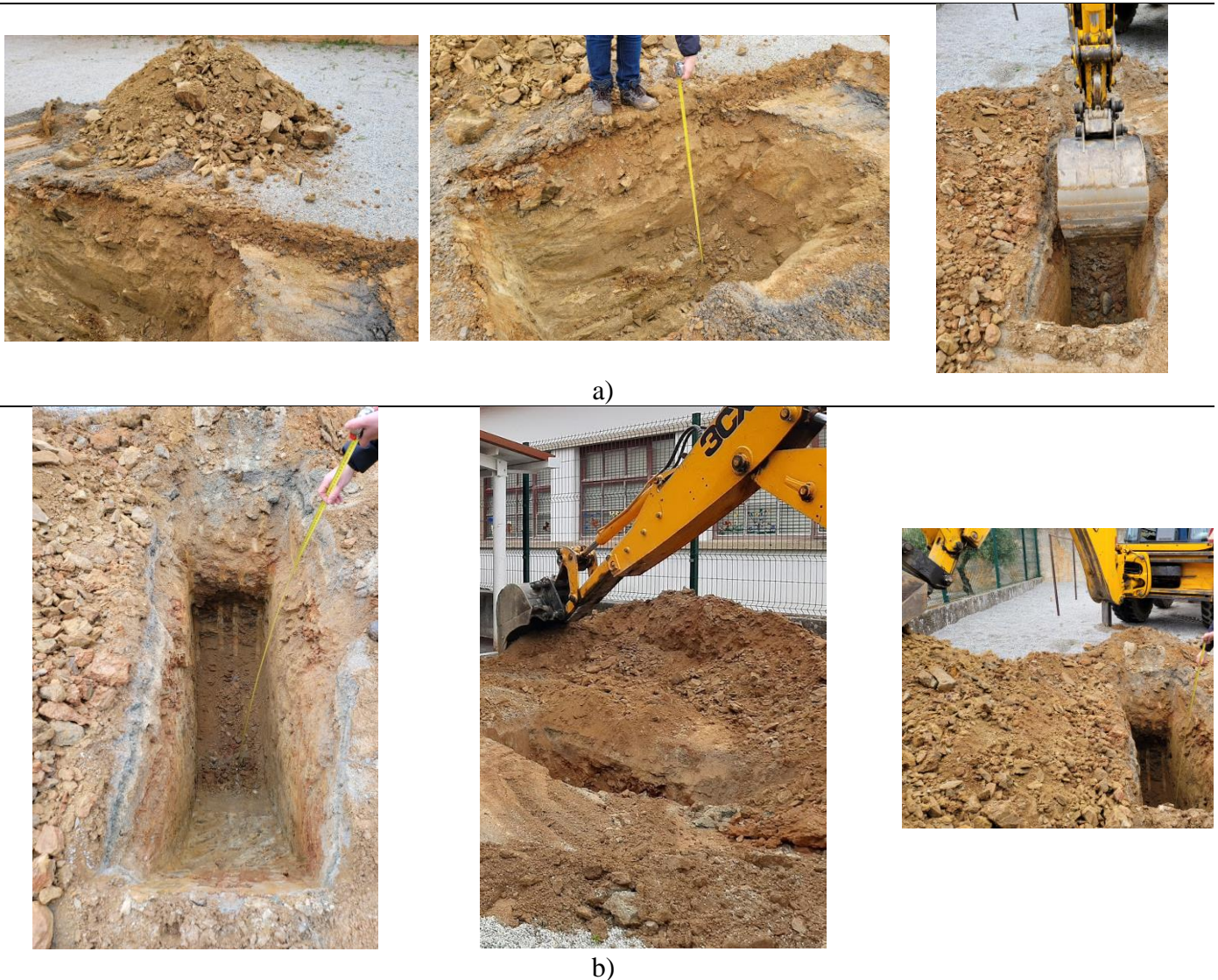
Figura 5 – Poços de prospeção: a) PI1; b) PI2
