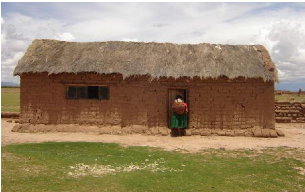
I.44 Raw earth house / Casa in terra cruda / Casa de tierra cruda
