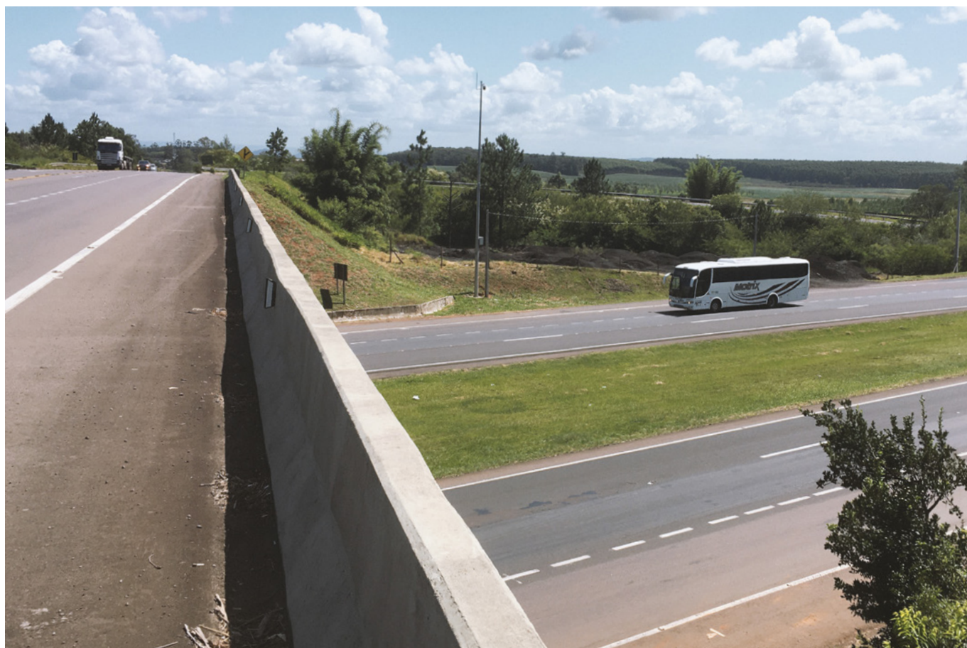
Fig. 20 - Viaduto RS-124 com BR-386, Montenegro (RS), 2022. Fonte: Autor.
