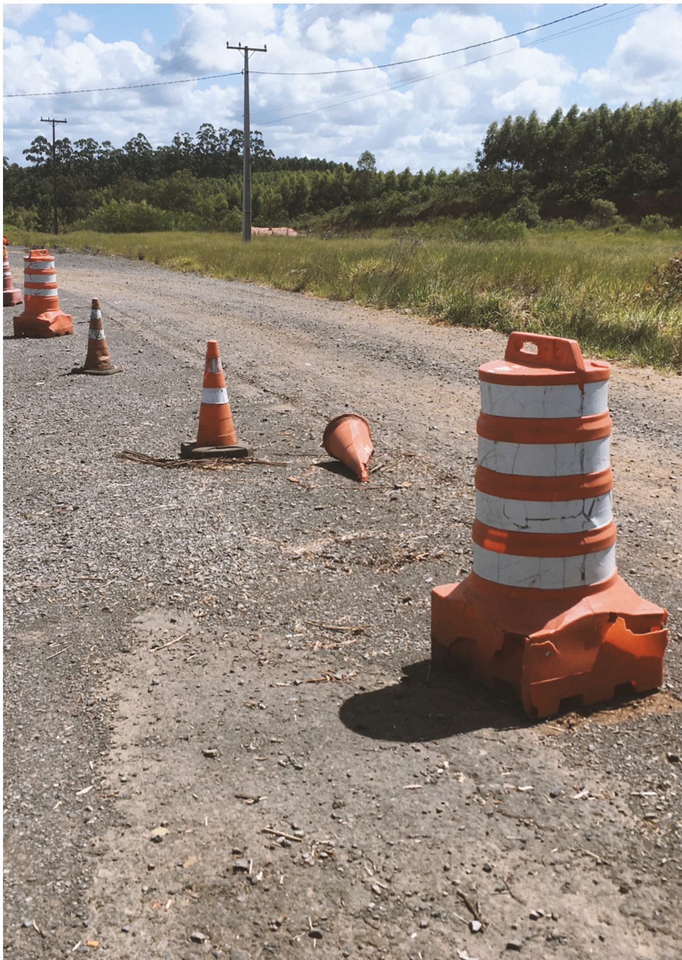
Fig. 22 - Canteiro de obras na RS-124, Calafate, Montenegro (RS), 2021. Fonte: Autor.
