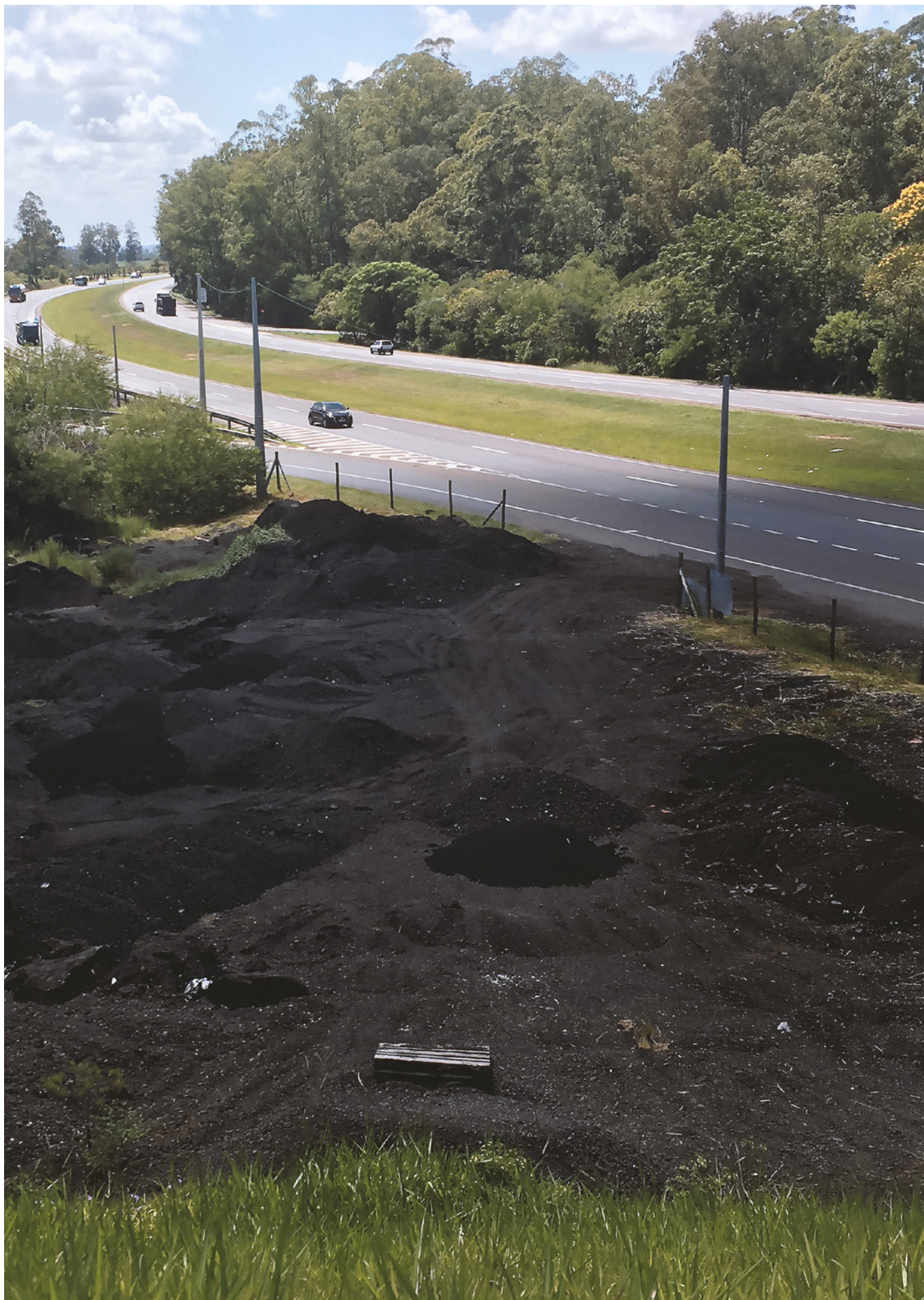
Fig. 18 - Canteiro de obras na BR-386, Bom Jardim, Montenegro (RS), 2022. Fonte: Autor.
