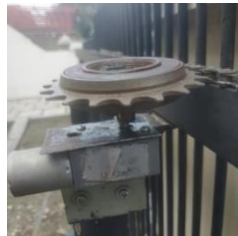
Gambar 12. Motor DC Telah Terpasang Pada Bracket Motor
