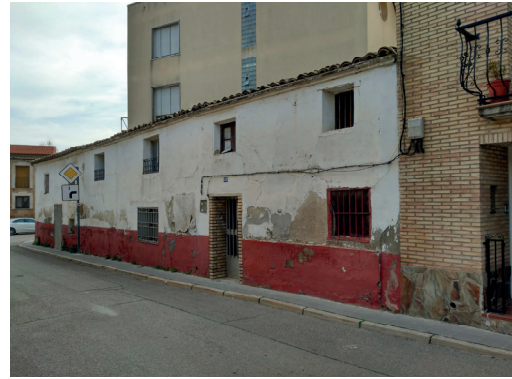
Figura 22: Foto previa a las actuaciones de Z.ABR20. Proyecto de Demolición Z.ABR20
