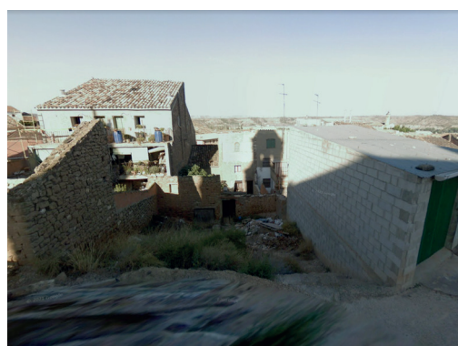
Figura 32: Foto previa a las actuaciones de Z.ABR21.
