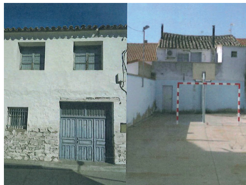
Figura 28: Foto previa a las actuaciones de Z.DIC20.
