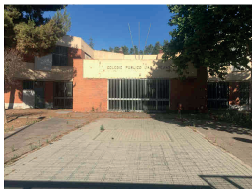
Figura 38: Foto previa a las actuaciones de T.ABR22.
