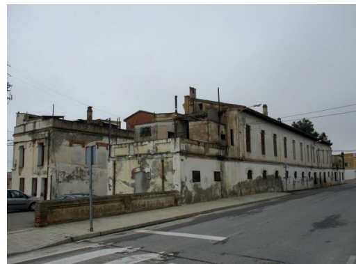
Figura 26: Foto previa a las actuaciones de Z.NOV20. Proyecto de Demolición Z.NOV20
