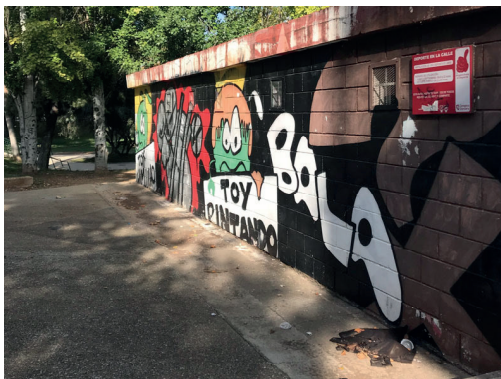
Figura 35: Foto previa a las actuaciones de Z.DIC21, (Vectuarios Torrerramona). Proyecto de Demolición Z.DIC21
