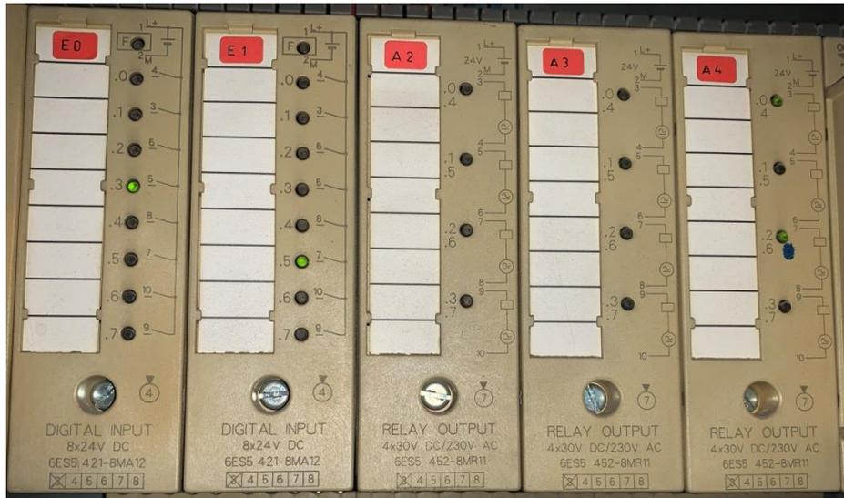
Ilustración 29. Módulo de entradas/salidas del autómatas S5
