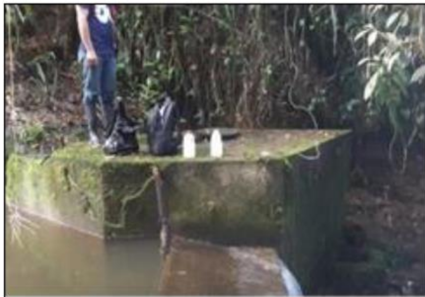
Figura 14. Inspección Bocatoma casco Urbano
