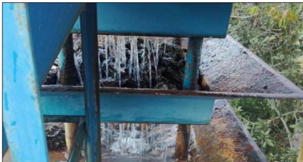
Figura Filtro de Carbón activado entrada PTAP
