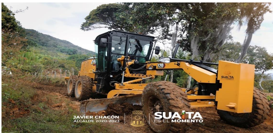
Figura 31. Adecuación de vías y terrenos de Suaita.
