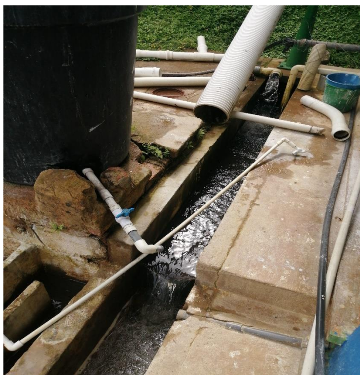
Figura 5. Arribo del caudal proveniente de la conducción.
