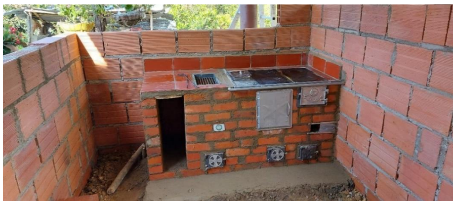
Figura 41. Construcción de estufas de leña ecoeficientes.
