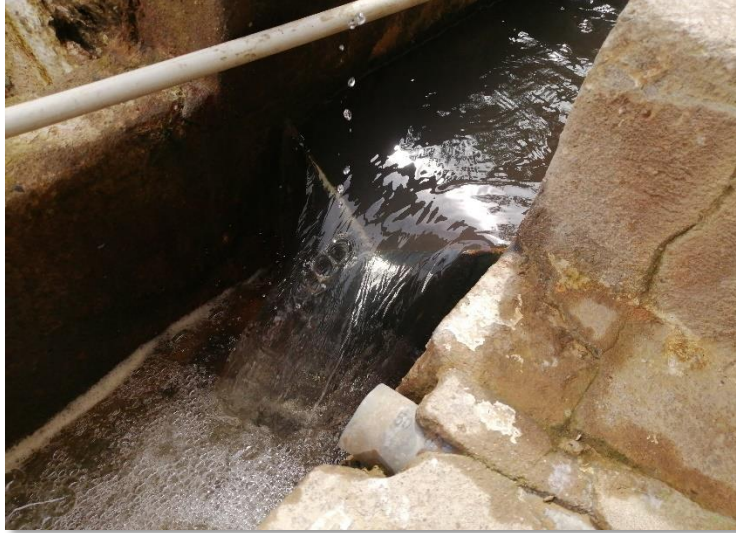
Figura 6. Proceso de mezcla rápida con vertedero triangular.
