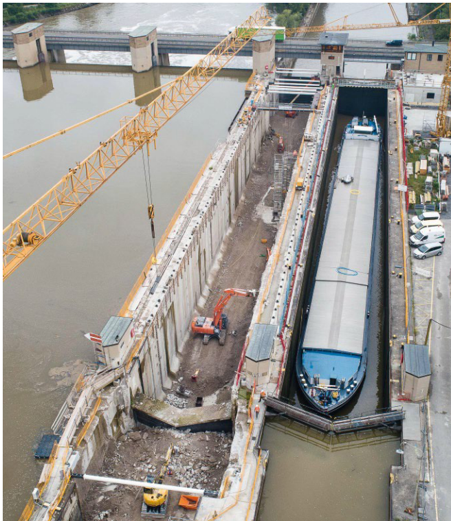
Bild 1: Schiffsschleusenanlage mit zwei Kammern aus Gewichtsstützwänden bei teilweise stattfindender Betoninstandsetzung Ship lock system with two chambers made of gravity retaining walls during partially carried concrete repair
