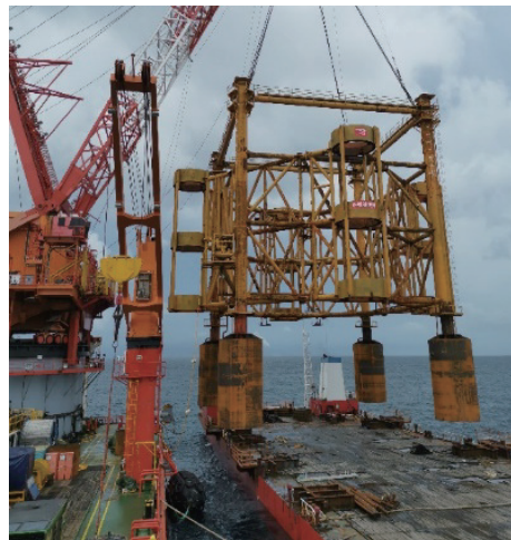
图 4 四桩平台架吊装
