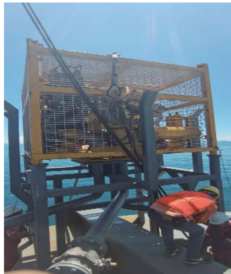
图 1 泵撬块与平台架的联接
