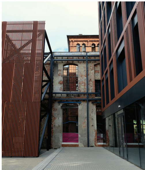
Fotografia 3. Połączenie nowoczesnych budynków z zachowaną ścianą budynku pofabrycznego
