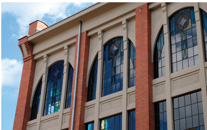
Fotografia 2. Witraże w oknach dawnej elektrowni
