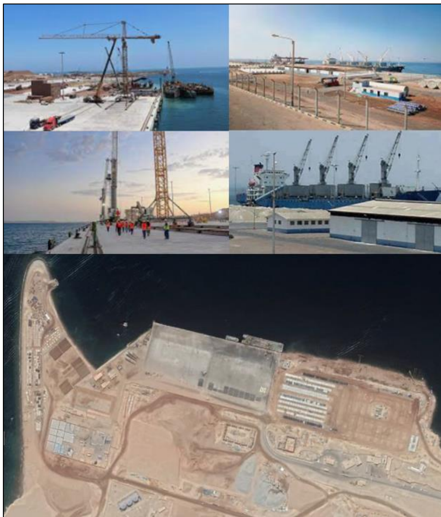
Figura 5.14 Obras de ampliación del Puerto General José de San Martín. Fuente: Imágenes de Google.
