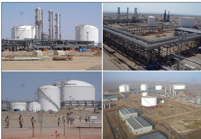
Figura 5.9b LGN del Perú. Instalaciones en tierra: planta de fraccionamiento. Fuente Google. Rendy. PNG
