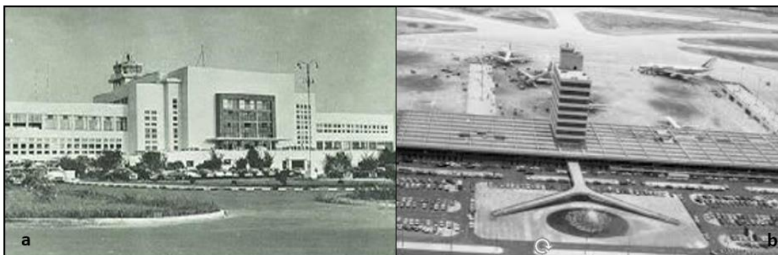
Figura 2.8 (a) Antiguo Aeropuerto de Limatambo. (b) Aeropuerto Internacional Jorge Chávez en su inauguración.
