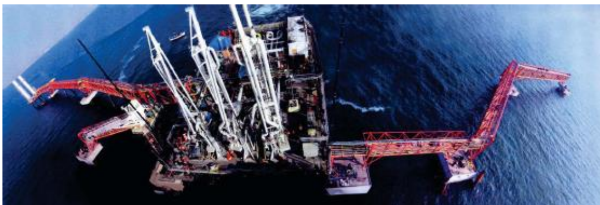
Figura 5.9a LGN del Perú. Instalaciones en aguas marinas para el abastecimiento de gas directamente a los barcos.
