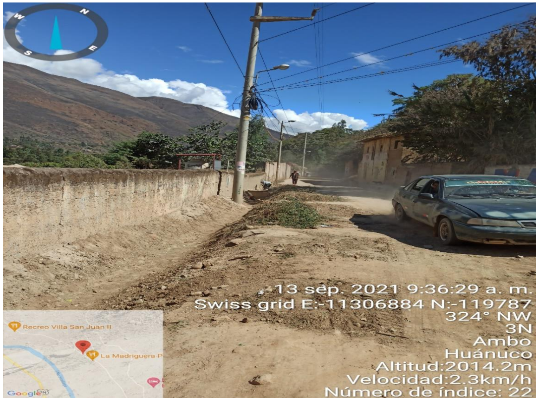
En la imagen se puede apreciar algunas viviendas que vienen sufriendo directamente el desborde de las aguas de la quebrada.
