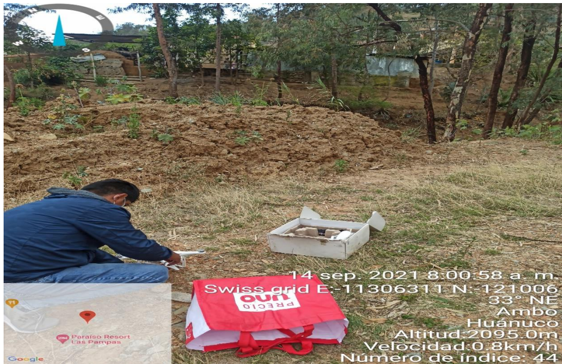
En la imagen se puede apreciar la colocación de las coordenadas para poder hacer el levantamiento topográfico con el Drones.
