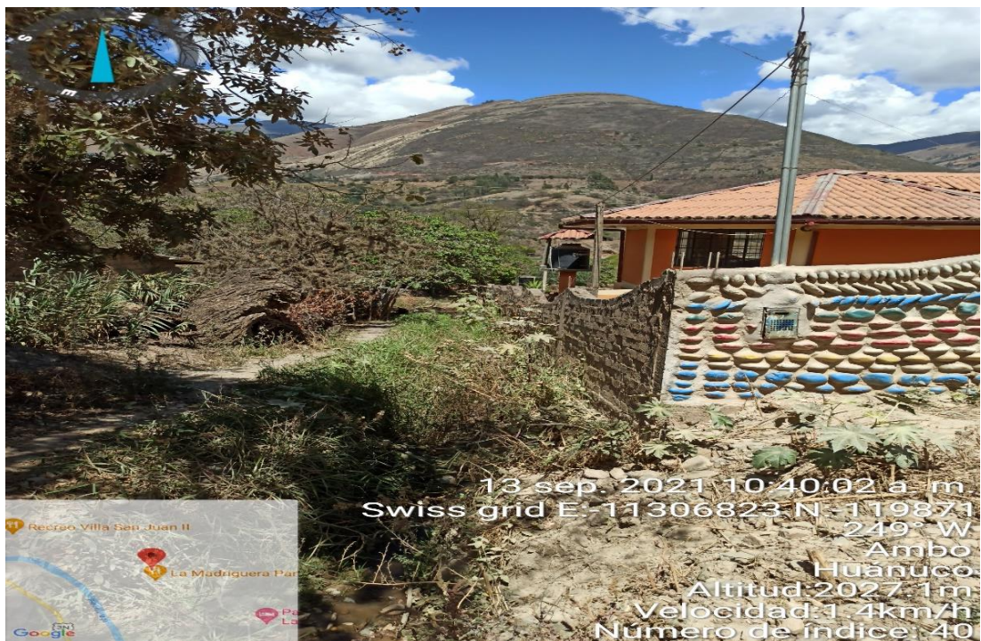
En la imagen se puede apreciar la ubicación de la vivienda que se encuentra al margen de la quebrada
