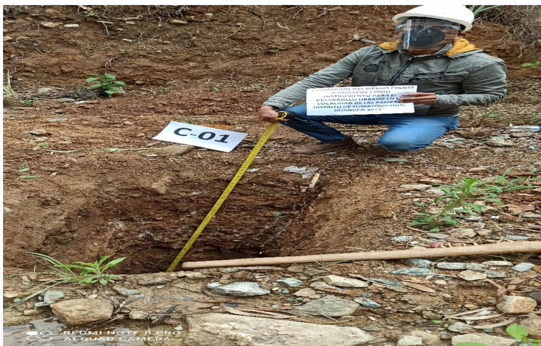
En la imagen se siguen observando la excavación de zanja que viene hacer la calicata N° 01.
