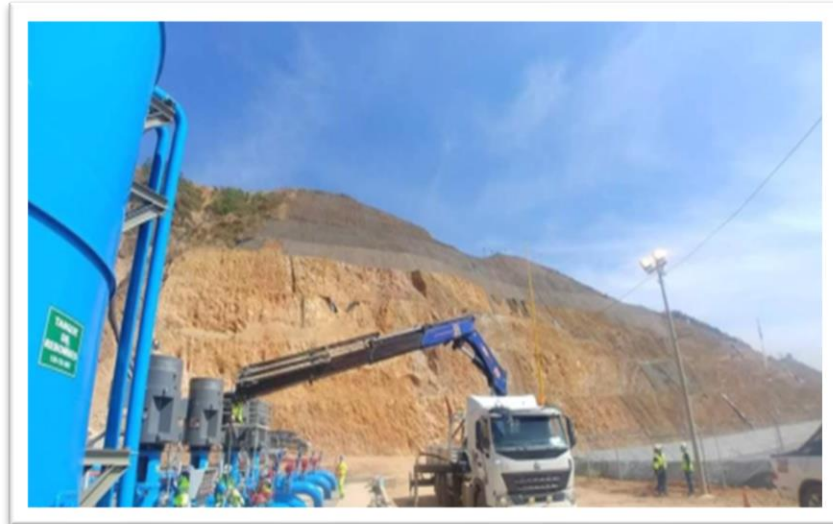
Figura 6 Izaje de bomba vertical con camión grúa 22 Tn Fuente: Elaboración propia.
