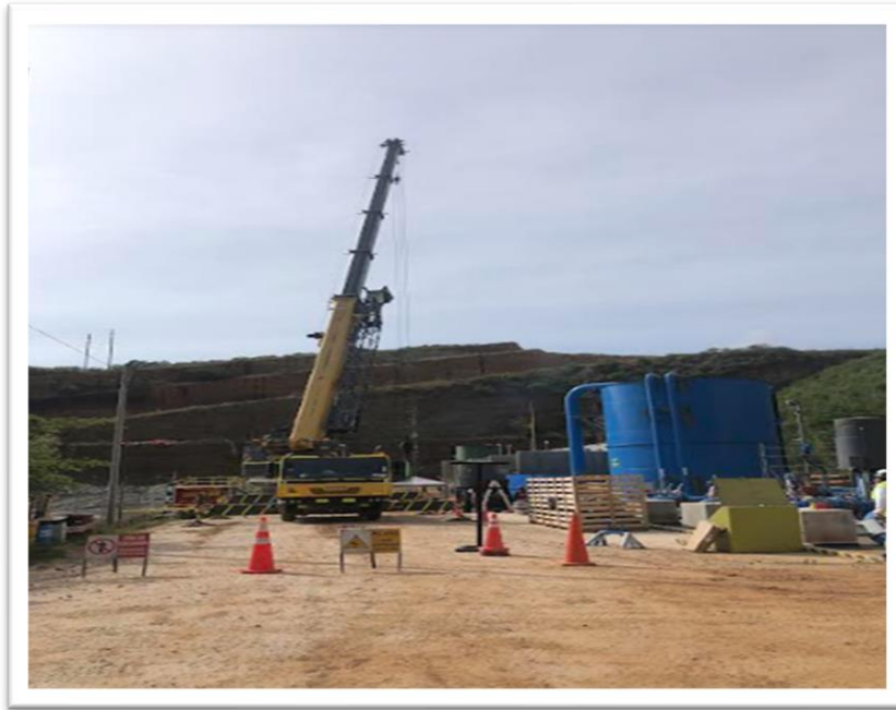
Figura 7 Izaje de bomba vertical con camión grúa telescópica Fuente: Elaboración propia.
