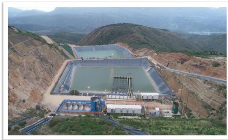
Figura 4 Plataforma de bombeo PLS2
