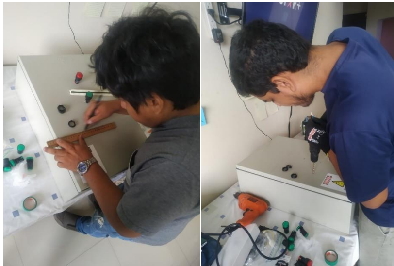
Anexo – 1 Montaje de pulsadores y focos pilotos.
