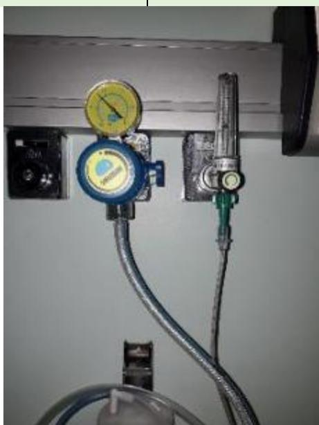
**Figura 2** – Rampa de vácuo conectada a aspirador e rampa de oxigénio.
