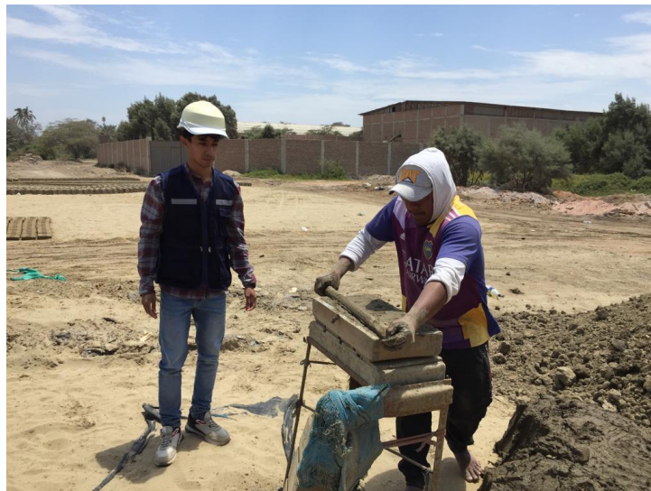
Figura 26. Mezcla colocada en la gabela
