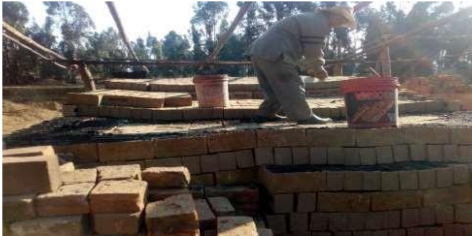
Figura 8. Preparación del horno para calcinado de ladrillos
