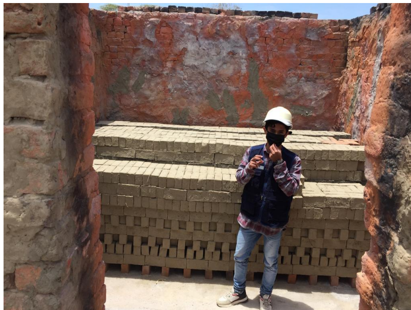
Figura 28. Ladrillos colocados en el horno
