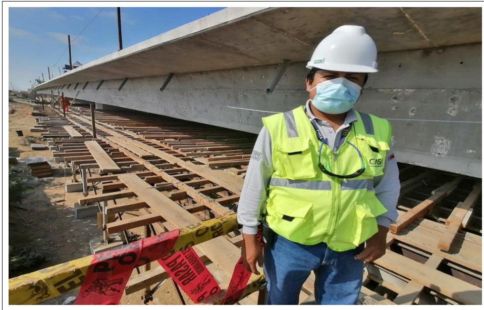
Figura 21. Investigador identificando la superestructura.
