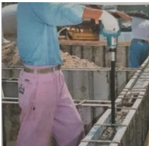
Fig.2 Vibrado de concreto (Jiménez, 2017)
