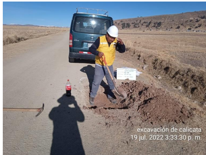
Figura 9. Excavación de calicatas
