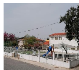
Figura 17. Fotografia do exterior da escola do 1.º CEB
