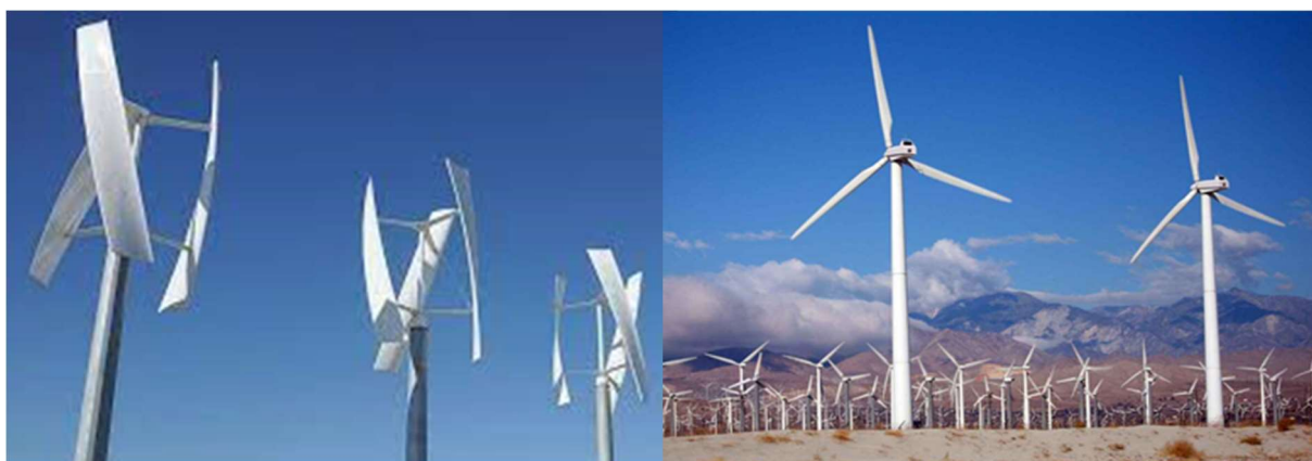
Il·lustració 10. Aerogenerador d'eix vertical (esquerra) i d'eix horitzontal (dreta) (Font: Renovables verdes)
