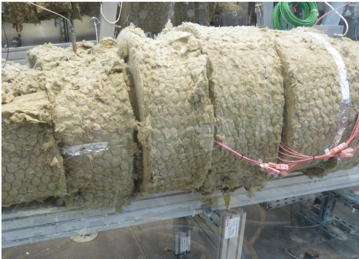
Abbildung 12: Wärmedämmung an den Flanschen.
