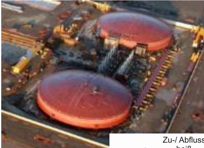
2-Tank Solarsalz Andasol
