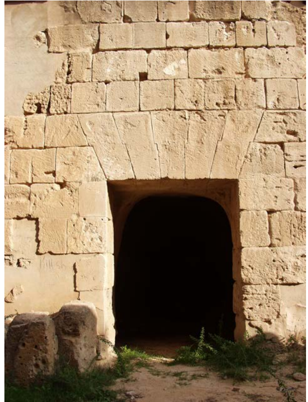
Fig. 11. Sabratha. Anfiteatro. Ingresso principale est. Porta con piattabanda dentata. Da Sud. Novembre 2010.
