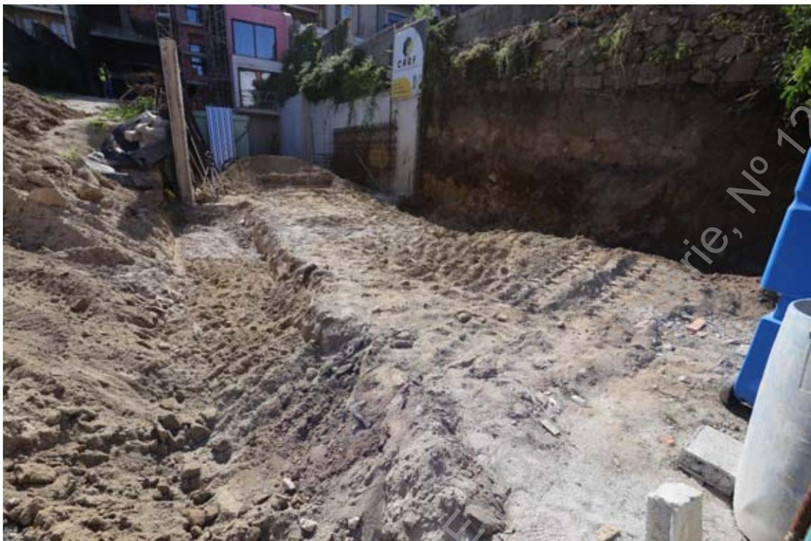
**Foto 41 (IMG\_9108)** – Acompanhamento da abertura de valas para a sapata de fecho da área de logradouro.
