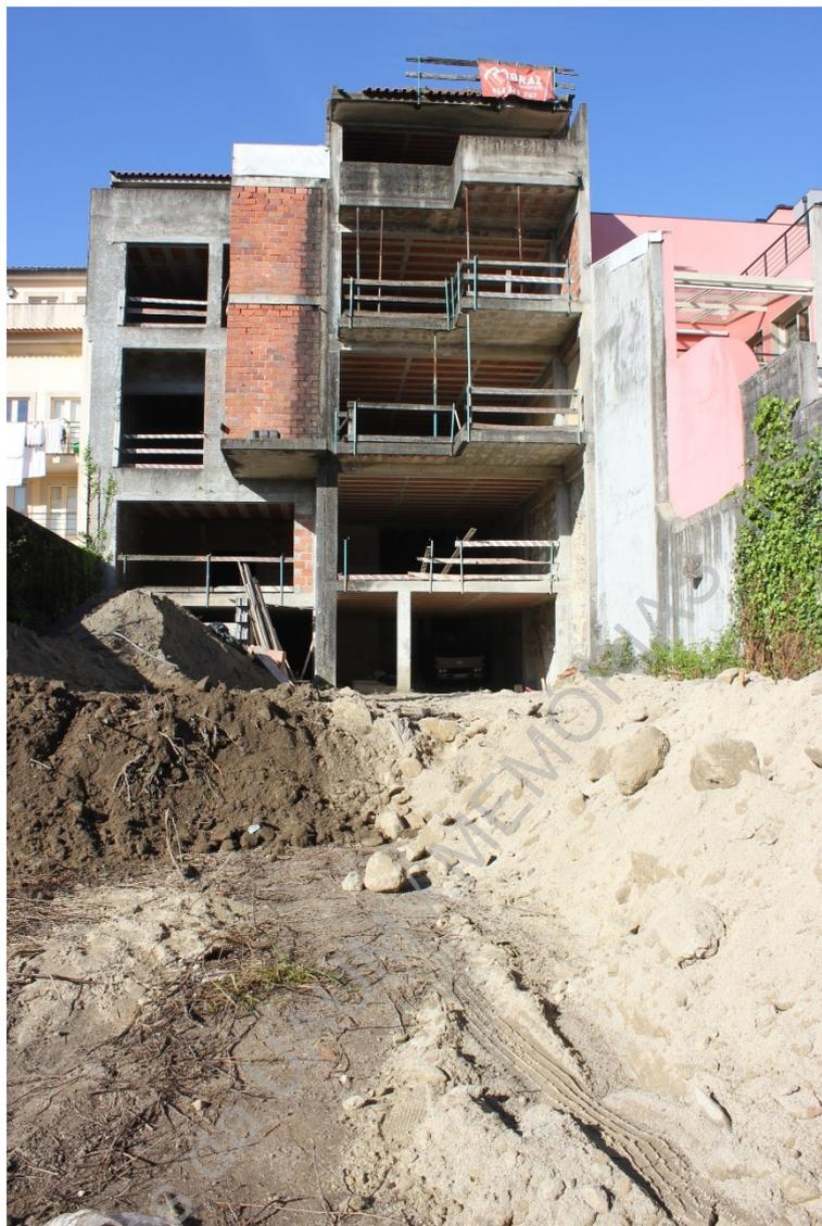
**Foto 34 (IMG\_0287)** – Acompanhamento dos trabalhos de desaterro na área de logradouro do lote intervencionado.
