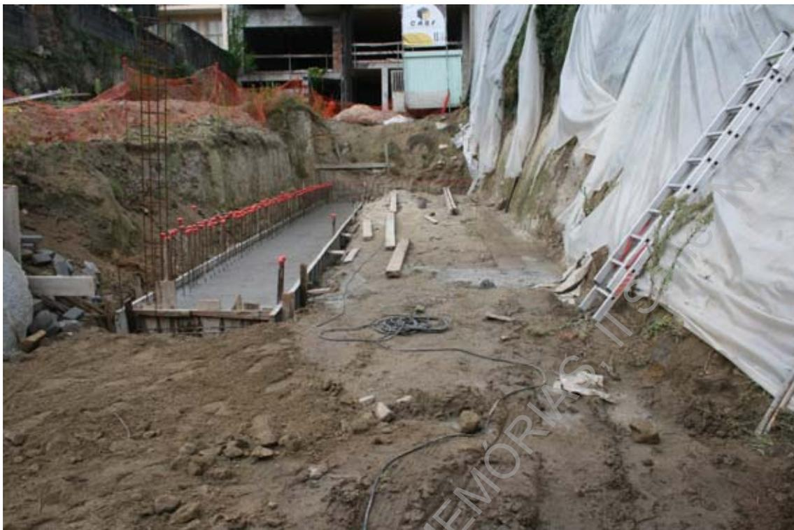
**Foto 39 (IMG\_1468)** – Acompanhamento da betonagem das sapatas para muro de delimitação da área de logradouro.
