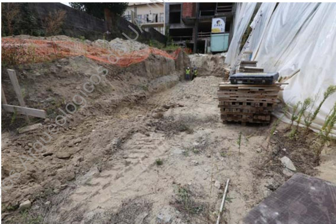
**Foto 38 (IMG\_4954)** – Acompanhamento da abertura de valas para implantação da sapata para muro de delimitação da área de logradouro para garagem.
