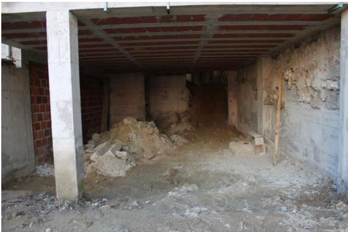
**Foto 32 (IMG\_0201)** – Perspetiva geral da decapagem do terreno no interior do edifício.
