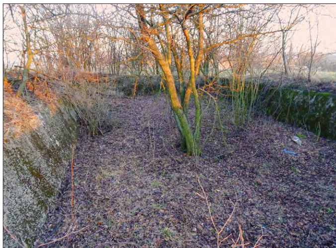
II. 16. Basen na wodę na Górze Chrapoń koło Zawady w gminie Mstów; K00 M1_B19. Fot. J. Trajdos, luty 2019 r.
