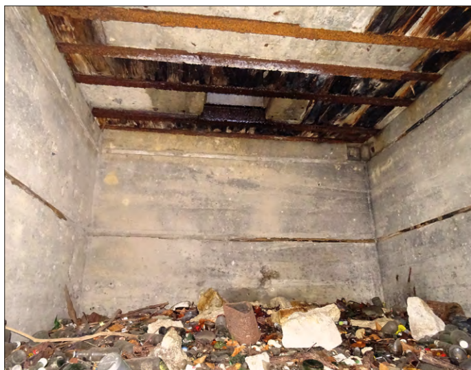
II. 12. Widoczny otwór na peryskop w stropie jednego ze schronów typu Regelbau 668 oraz jego brak w kolejnym; K00 07_B3; 08_B9.
