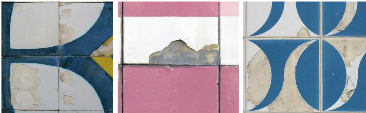
**Figura 4.6** Exemplos de perda de vidrado do Tipo C (sem chacota aderente): esquerda) azulejos da Fábrica Constância; centro) azulejos da Fábrica Viúva Lamego; direita) azulejos da Fábrica Estaco.
