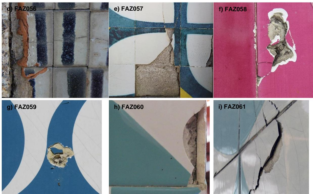
**Figura 3.4** Áreas dos painéis de azulejos de exterior de onde foram colhidas as amostras.
