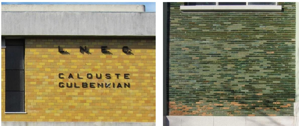
**Figura 2.7.** Dois exemplos de revestimento cerâmicas vidradas: esquerda) Edifício Calouste Gulbenkian, 1960, Laboratório Nacional de Engenharia Civil, Avenida do Brasil, Lisboa; direita) degradação presente neste tipo de revestimento. Casa da Moeda, Avenida de António José de Almeida Nº 42, Lisboa.
