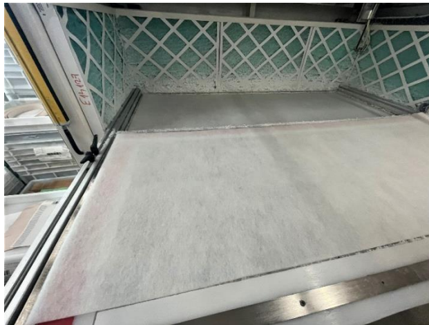
Figura 58 - Colocação do filtro de gaveta sobre as placas vermelhas.
