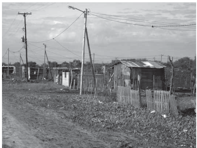
Figura 13. Conexiones eléctricas precarias e informales en asentamientos del AMGR Fuente: elaboración propia
