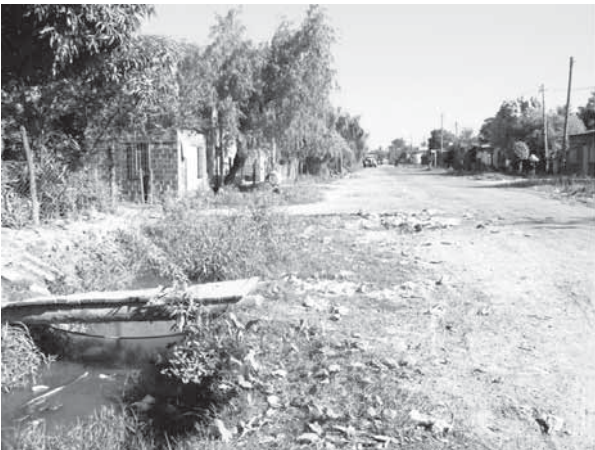
Figura 8. Conexiones informales y precarias Fuente: elaboración propia
