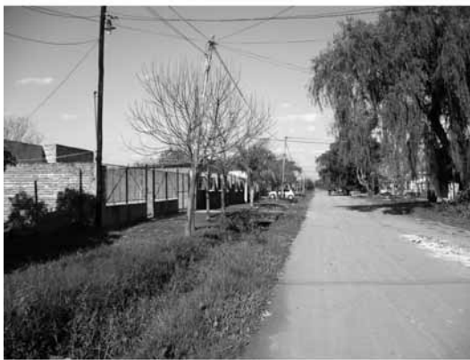
Borde Noreste. Terreno del ferrocarril ocupado.
