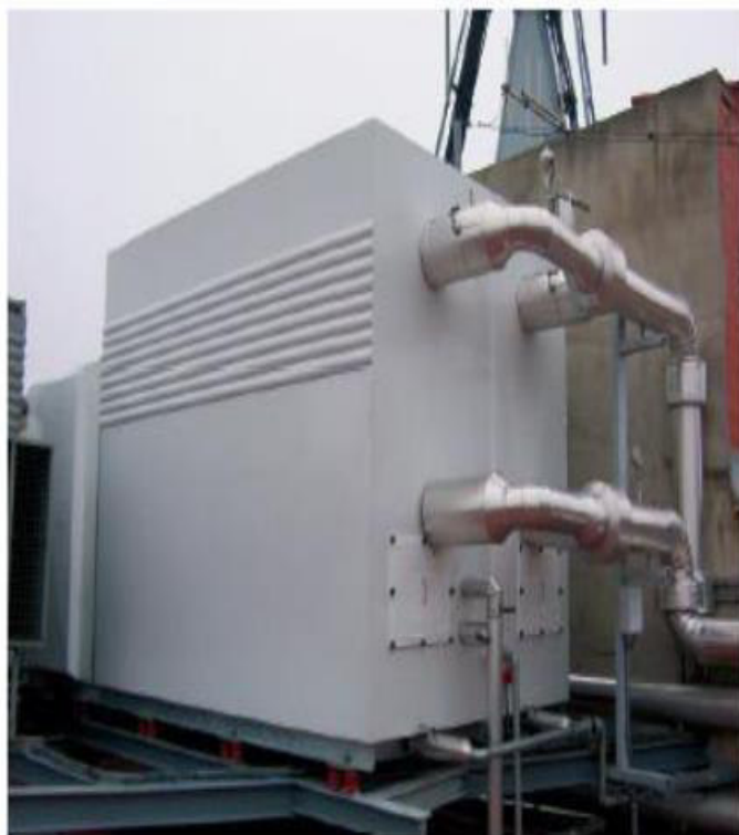
Figura 9. Torre de enfriamiento Mixta
