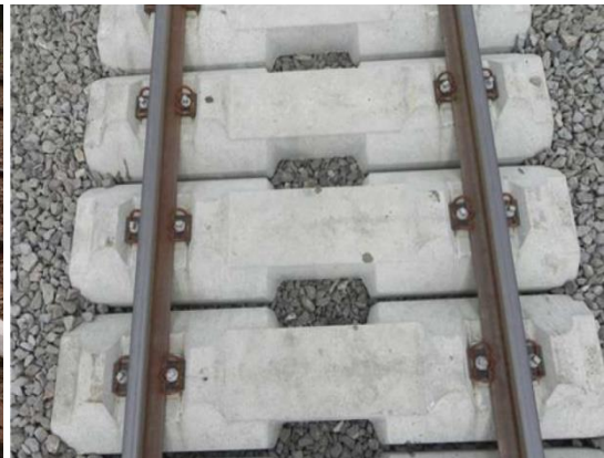
(d) wide sleepers (Auersch et al., 2014)
