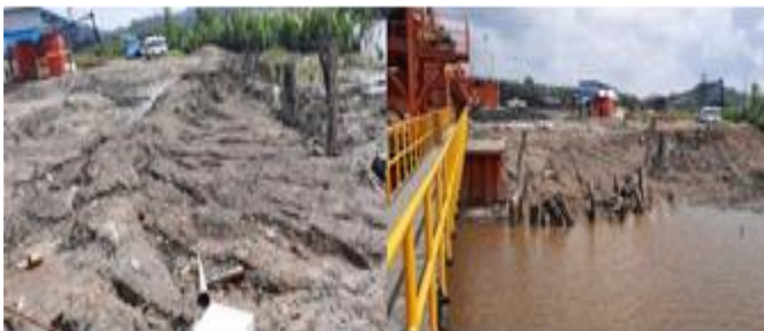
Gambar 1. Kondisi Tebing Sungai di Lokasi Proyek BLC2 PT. Kutai Energi
