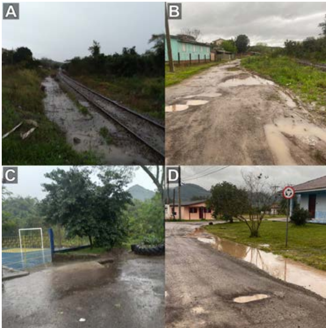
Figura 6. Fotos de alagamentos no bairro Km3, nas imediações da escola.
