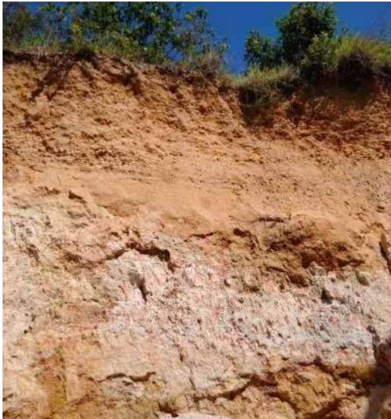
Figura 6 – Perfil de solo na face da erosão
