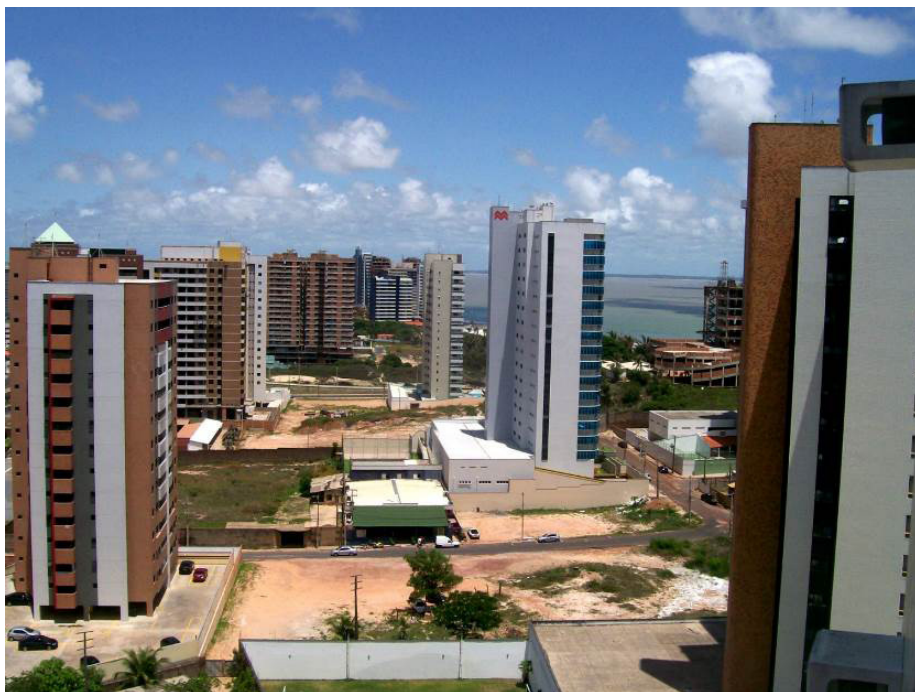
Figura 10 - Presença de Prédios residenciais construídos e em construção na franja costeira de São Marcos. Fonte: Masullo (2010).
