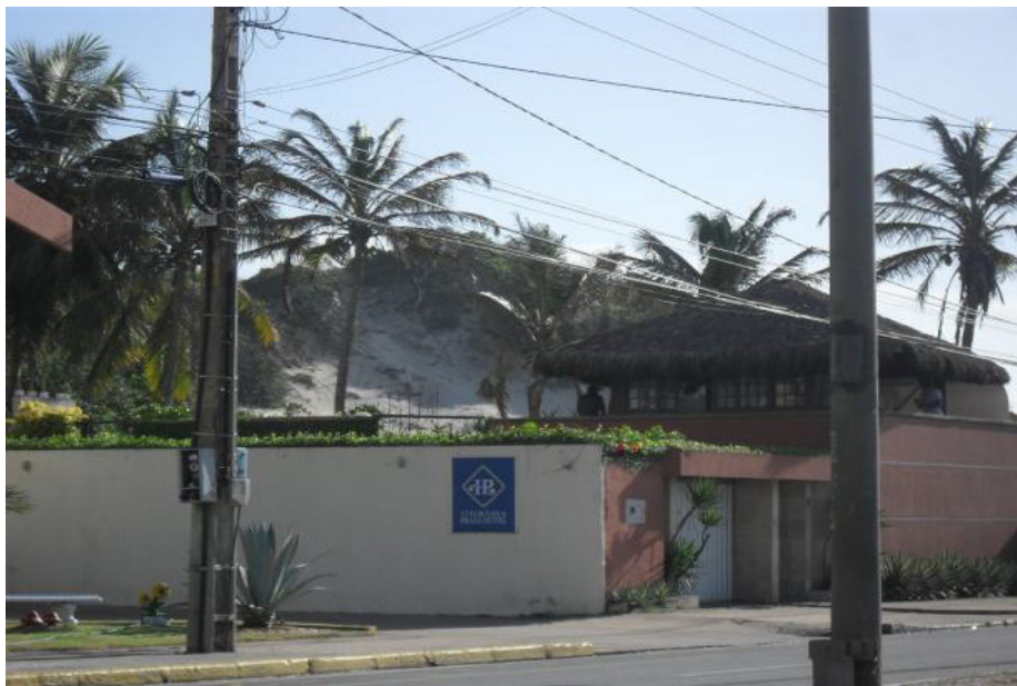
Figura 8 - Construção na encosta das dunas.
